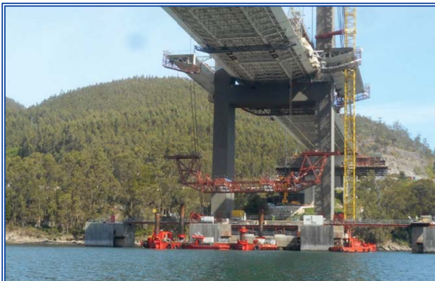
Colocación Carro de Izado
