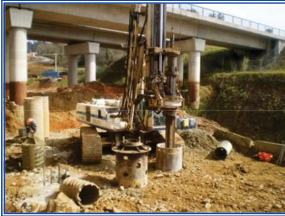
Asesoría Geotécnica Ampliación Capacidad Autopista AP-9 (Santiago de Compostela)
