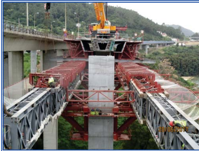
Avance Autocimbra Viaducto de Acceso Sur Margen Derecha
