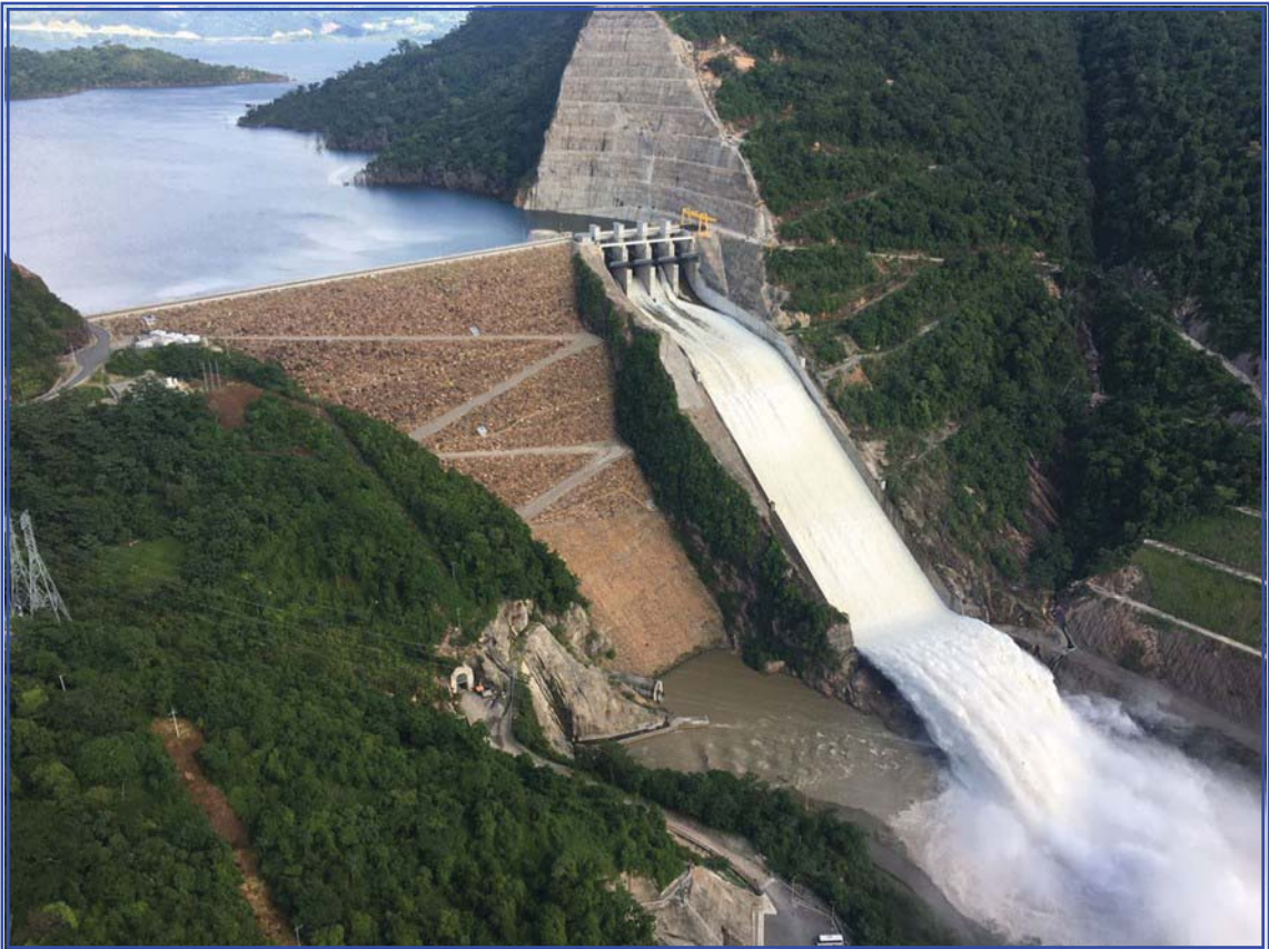
Presa de C.H. Sogamoso (CFRD, 190 m altura)
