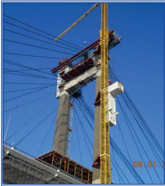
Izado de Piezas para Materialización Estructura Superior de Pilas (para alojar Nuevos Tirantes)
