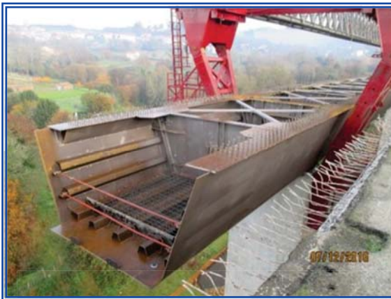
Viaducto de Angrois (ampliación de 2 a 5 carriles por sentido)
