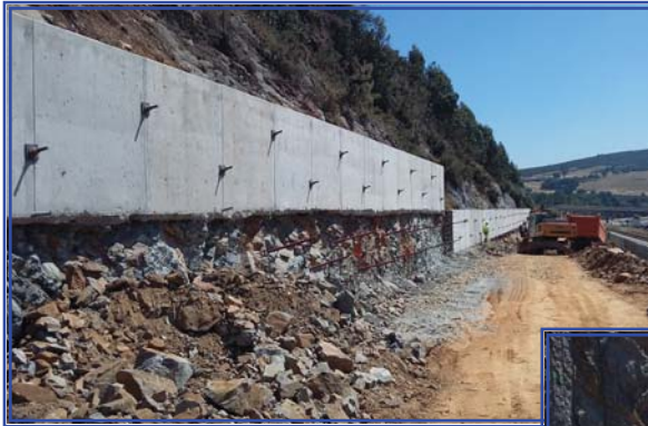
Muro 2 (Zona Norte) Muro de Hormigón anclado descendente (ampliación de 2 a 5 carriles por
