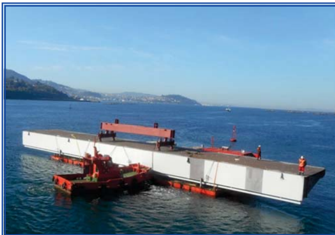
Transporte Dovela (por Mar) En la Fotografía se muestra la Dovela 0 (7 m · 40 m)
