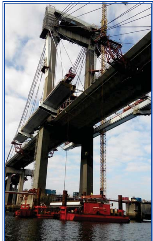
Izado de Dovela Tipo
